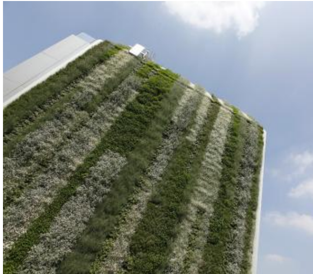
IMAGEN 157: Muro verde en multifamiliar
