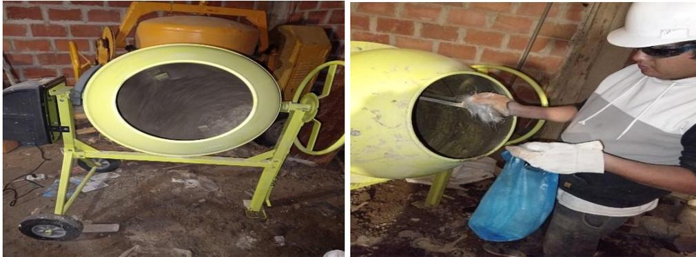
*Nota.* Se aprecia el premezclado del concreto con diferentes porcentajes de fibra de vidrio.
