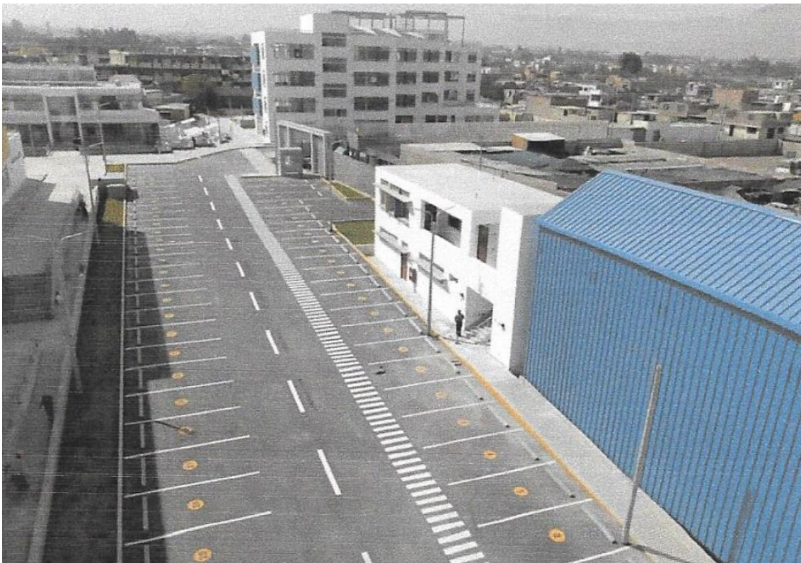
Vista Fachada Taller y Laboratorio de estructuras
