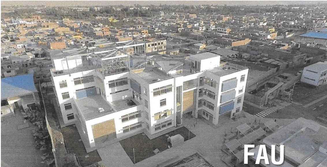
Vista Fachada Frontal FAU
