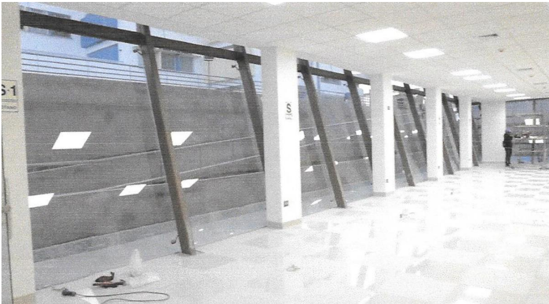
Muro cortina en SUM (Vista desde el interior)
