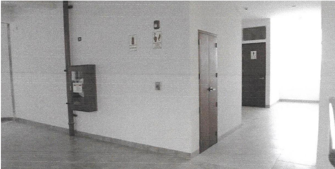
Vista interior área de circulación FAING (Bloque 1)
