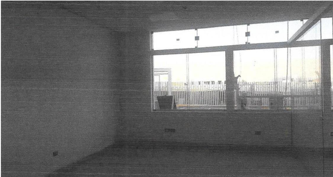
Vista interior Sala de acreditación FAING (Bloque 1)
