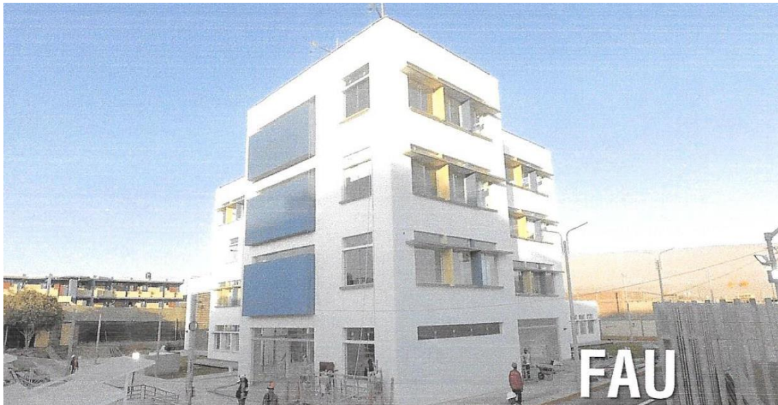
Vista Fachada lateral derecha FAU
