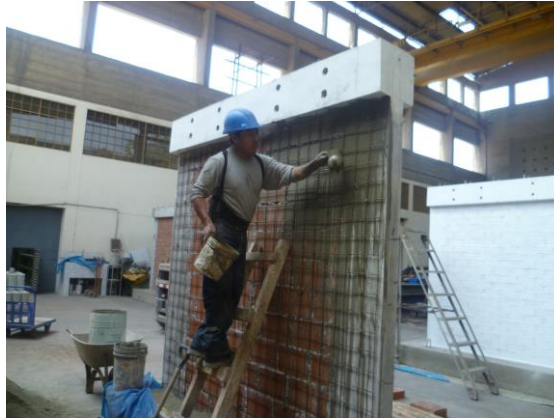
Figura – 08: Colocando la lechada de concreto
