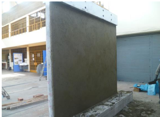
Figura – 09: Muro reparado
