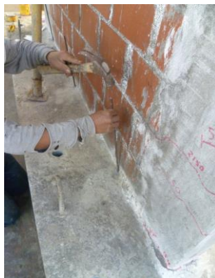
Figura – 07: Colocación de las varillas de acero
