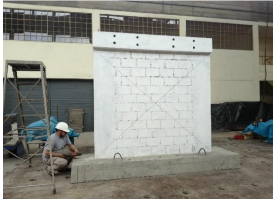
Figura – 05: Vista final del muro
