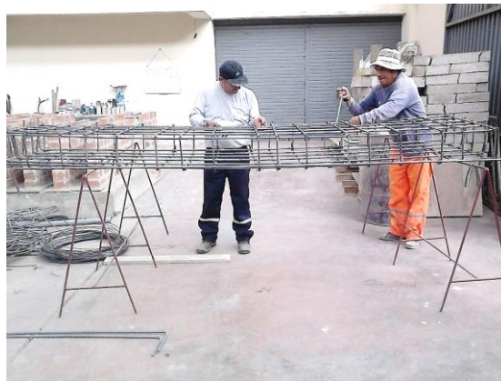
Figura – 03: Habilitación de acero para columnas y vigas
