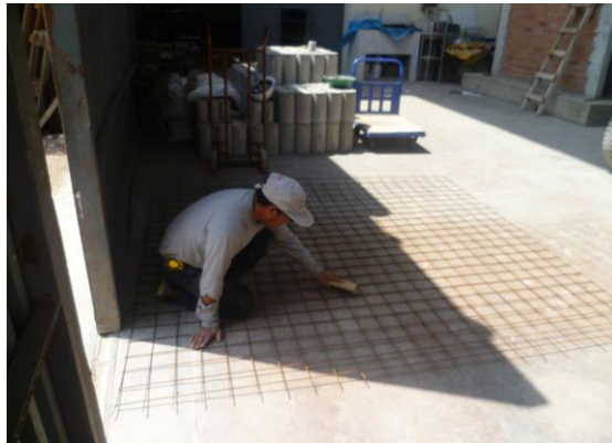
Figura – 06: Alistando la malla electrosoldada 1/4" para su instalación.
