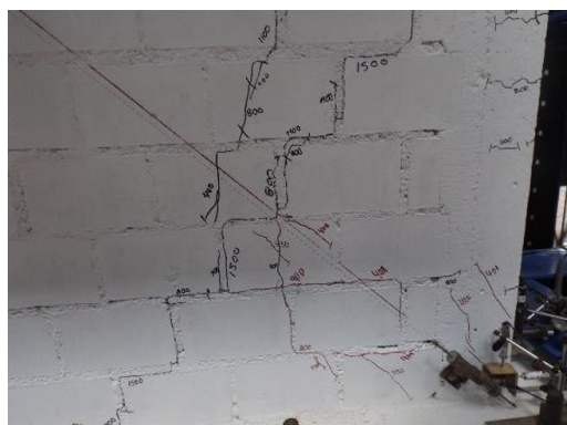
Figura – 28: Formación de grietas diagonales en la parte inferior Oeste de la cara Norte para una distorsión de 1/400 en el 2º ciclo.
