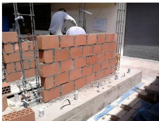
Figura – 04: Dentado del muro
