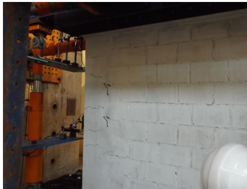
Figura – 18: Formación de pequeñas grietas cercanas a la columna Oeste a una distorsión 1/1500.
