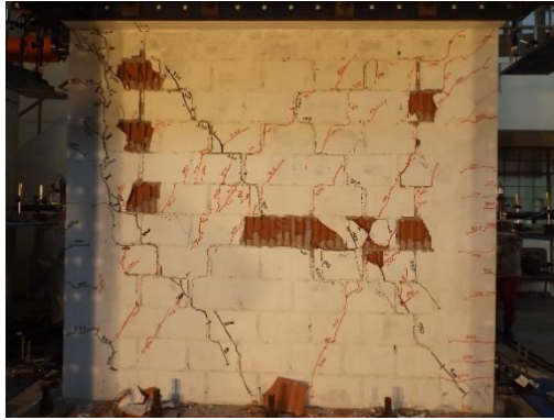
Figura – 23: Estado final del muro para una distorsión 1/150. Fuente: Ensayo de carga cíclica de tres muros escala natural. 2016
