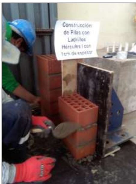
Figura 4. Pilas con Ladrillos Hércules I con 1 cm de espesor
