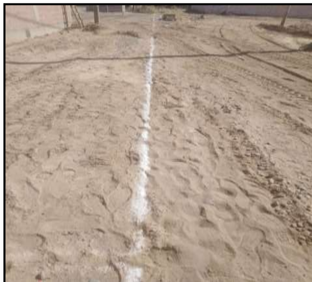
Figura 12 Replanteo inicial de obra
