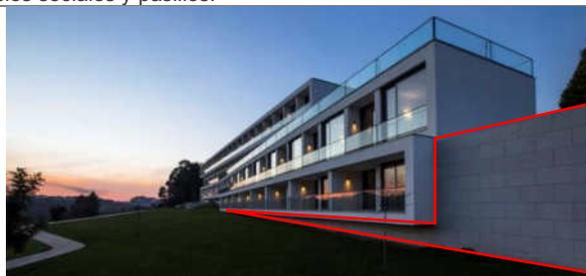
Se ha utilizado fachaleta de piedra como revestimiento inferior del equipamiento, y los ventanales de vidrio han sido instalados para completar el diseño.
