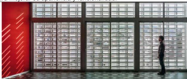
Se utilizó el vidrio con perfiles de aluminio en las ventanas para lograr una combinación de elegancia y resistencia, permitiendo así una adecuada iluminación natural y un buen aislamiento térmico.
