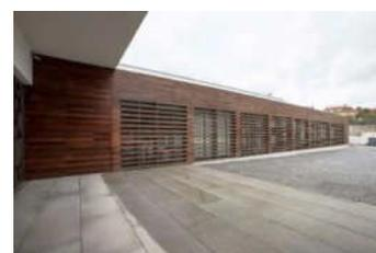
Se utilizó revestimiento de estructura de barras de madera entrelazadas horizontalmente.
