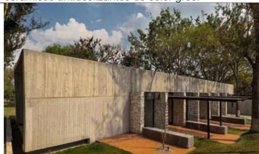
El revestimiento tanto del interior como del exterior del equipamiento se realizó con concreto expuesto, vidrio y perfiles de aluminio de color negro.
