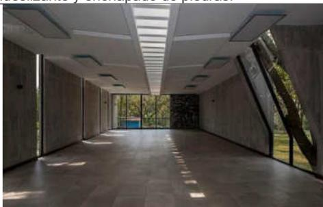
Se utilizó revestimiento en el techo compuesto por paneles de fibra de vidrio, los cuales presentan diversas ventajas. Estos plafones son fáciles de limpiar y ofrecen resistencia al moho y los hongos.
