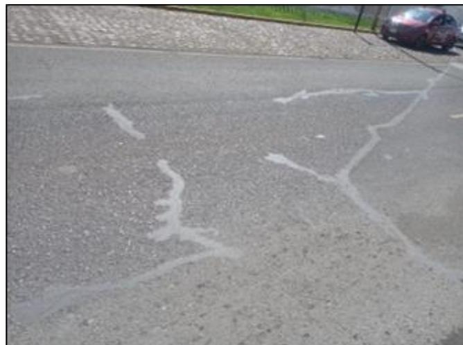
Como se muestra en la figura 5 se ve la presencia de agrietamientos en el límite lateral de la carpeta asfáltica y en parte del relleno sobresaliente de la tapa de desagüe.
