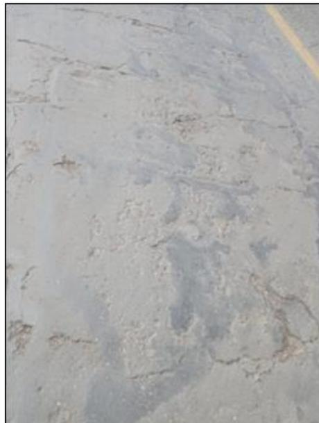
En la figura 7, se muestra el deterioro del pavimento es una preocupación fundamental en la evaluación de la rugosidad y la calidad de la carretera. Este fenómeno se debe a una combinación de factores, incluyendo el tráfico constante, las condiciones climáticas y el envejecimiento del pavimento. La imagen proporciona una representación visual de estos problemas y permite a los lectores comprender cómo influyen en las condiciones de la carretera evaluada.
