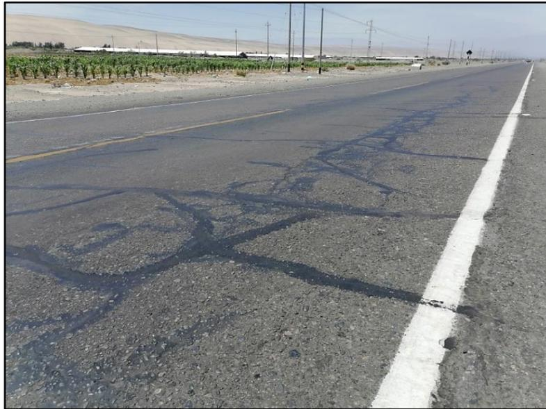
La figura 10 señala que en la carretera nacional PE-1SD kilómetro 5+000 al kilómetro 7+000 (2 kilómetros), evidencia pulimiento de agregados, baches, ahuellamiento, fallas de agrietamiento en todo el tramo de 2 kilómetros.
