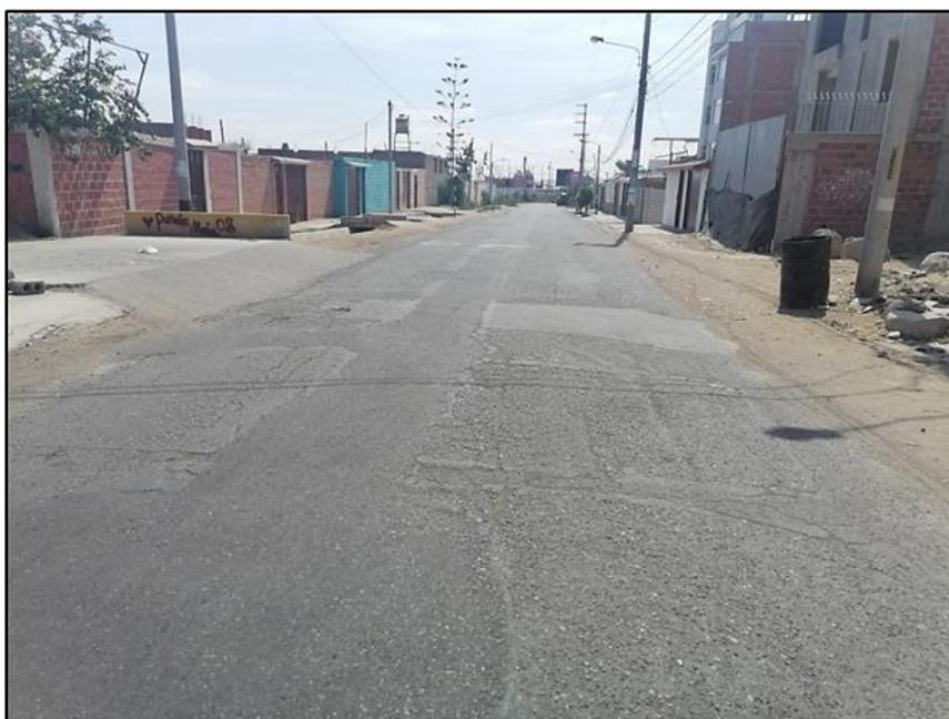
La Figura 2 muestra la Avenida Circunvalación Norte en la Provincia de Tacna, se identifica fallas en el pavimento flexible, concretamente: baches con nivel de severidad alto (H), pulimiento de agregados, desnivel de carril de severidad alto (H), desprendimiento de agregados de severidad alto (H) y que en la actualidad existe un alto flujo de tránsito de autos, station wagon, camionetas, buses (2E, 3E), camión (2E,3E), semi (2S1/2S2) en la Avenida Circunvalación Norte.
