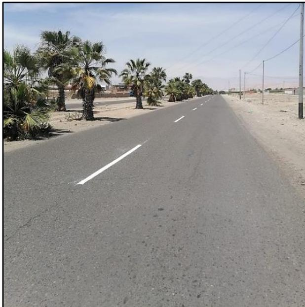
La Figura 4 muestra que en la Avenida Celestino Vargas ubicado en el Distrito de Pocollay – Provincia de Tacna no se observa un buen acabado superficial del pavimento y a la vez está presente la presencia de fallas en el pavimento flexible, en manera de: depresión, grietas longitudinales y transversales, baches, hinchamiento.
