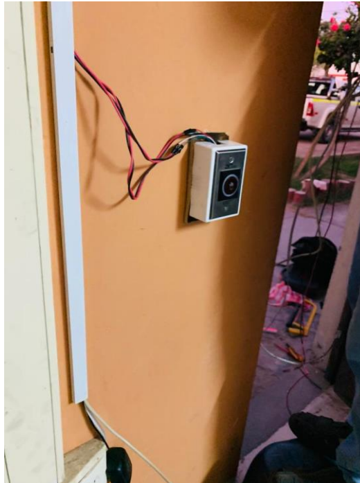
Colocación del botón no touch en el interior del área
