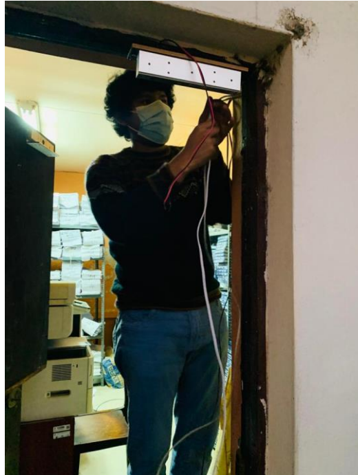
Colocación y cableado del electroimán
