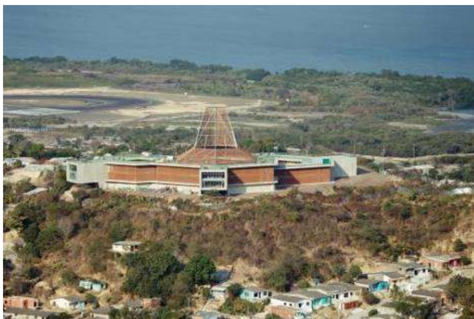
IMAGEN 30: VISTA PANORÁMICA ESCUELA LOMAS DEL PEYÉ FUENTE: ARCHIDAILY PERÚ
