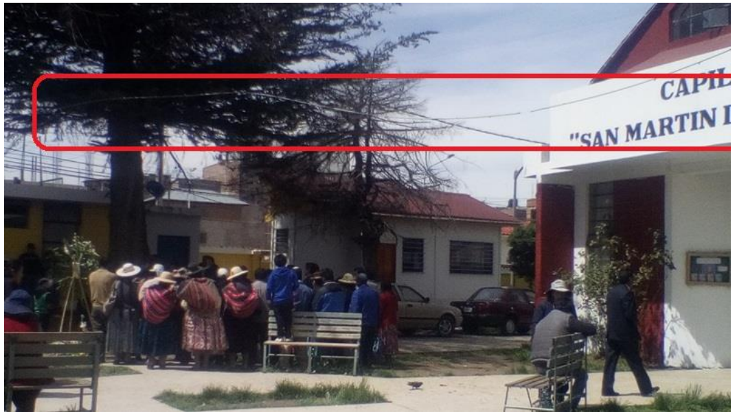
Figura 37: Tubería de PVC que con mucha distancia la cual estrangula el cable
