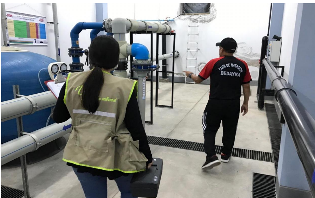
Figura 28. Inspección de la Casa de Maquinas de la Piscina I.E. Francisco Antonio de Zela
