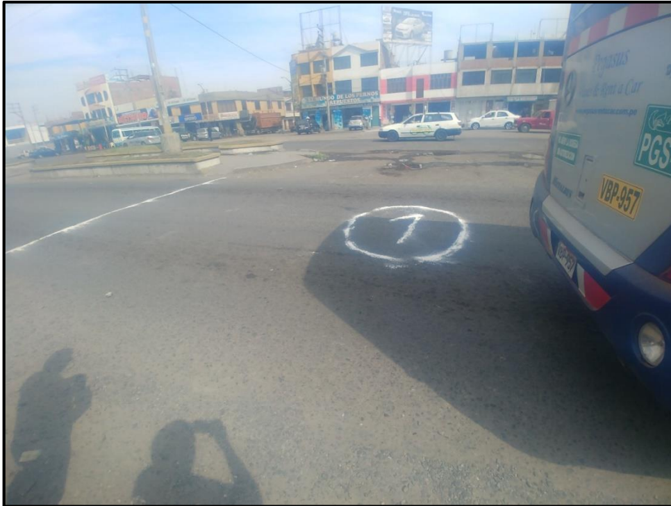
Evaluación de pavimento en calzada de bajada
