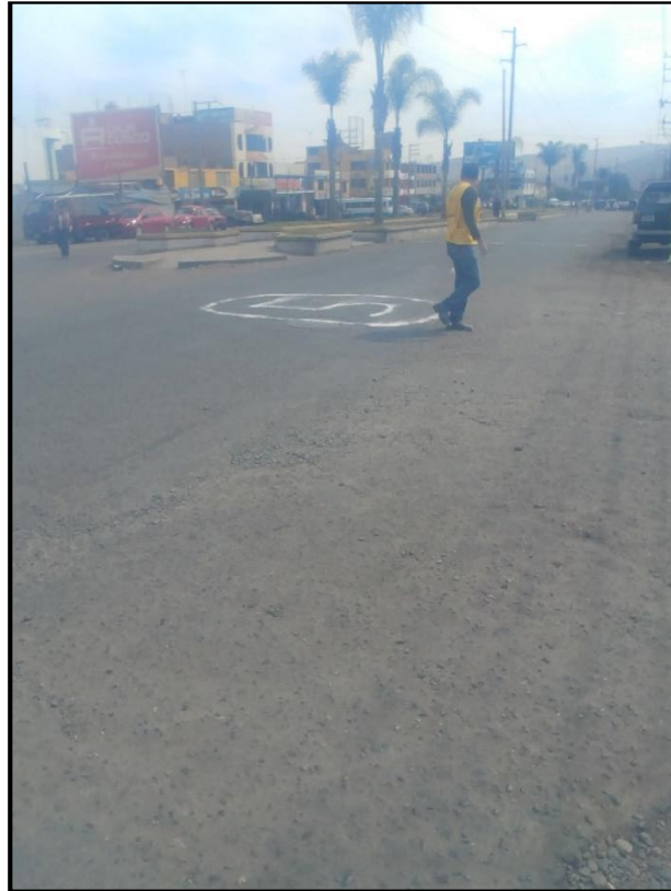
Desprendimiento de agregados
