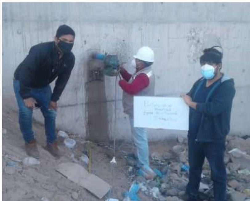
Figura 42 : Perforación de la Muestra 01 con equipo de Diamantina.
