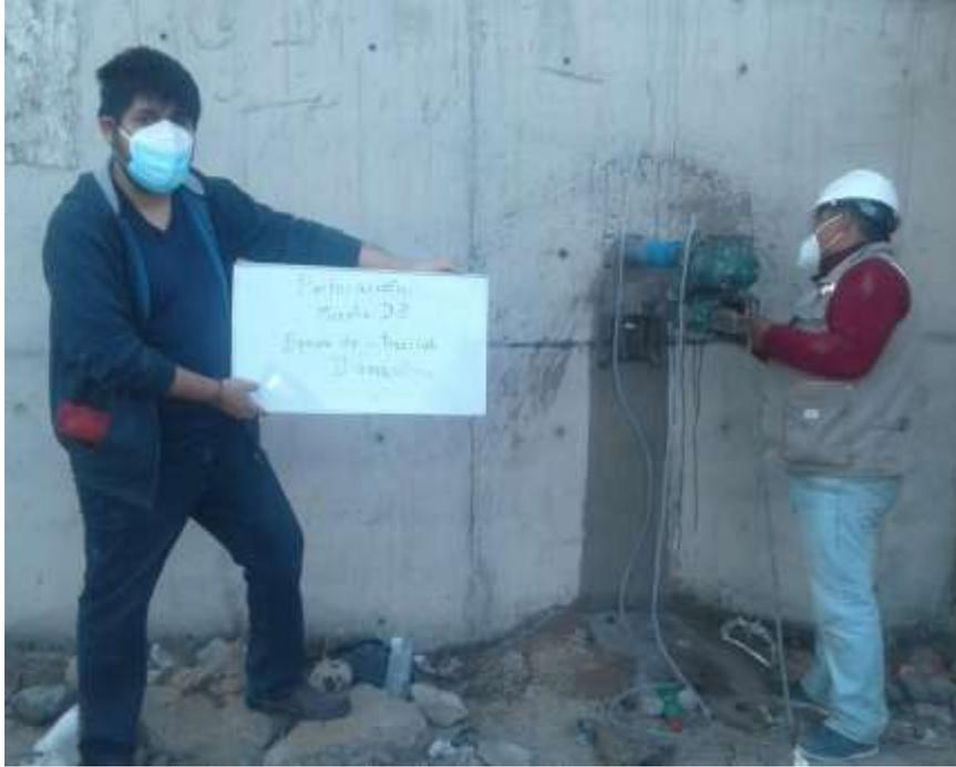
Figura 45: Perforación de la muestra D2 con el equipo de diamantina en el punto 2 de estudio.
