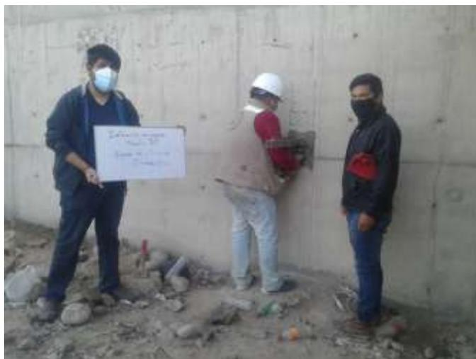
Figura 29 : Instalación de la base del equipo de extracción diamantina
