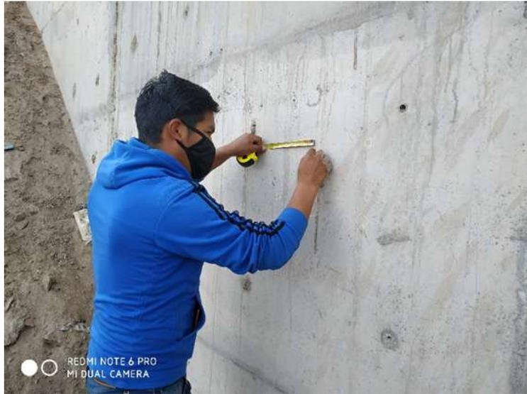
Figura 14: Trazado de la cuadrícula con tiza para el ensayo de Esclerómetro.
