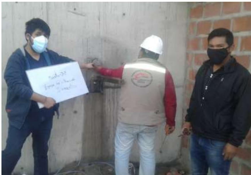
Figura 46 : Extracción de la muestra D2 del muro de contención.
