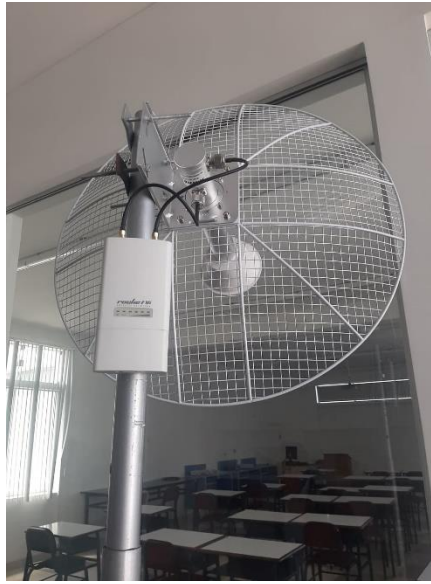
Figura 11: Laboratorio de Telecomunicaciones
