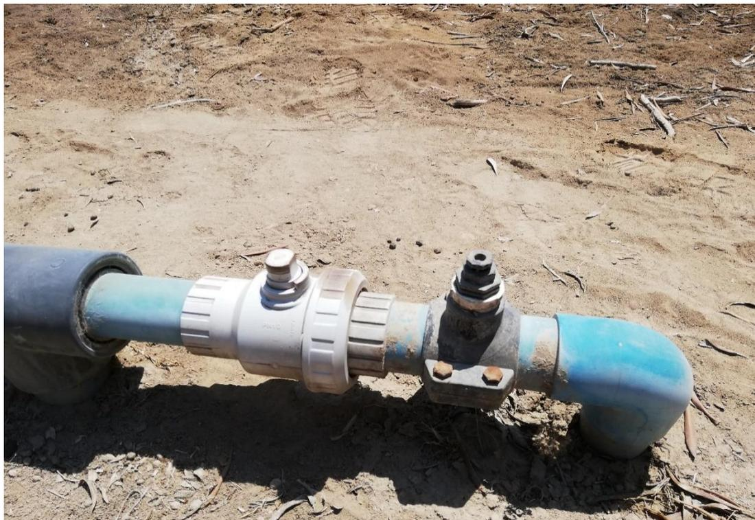
*Figura 37. Tubería principal para el riego, una troncal de 2"*
