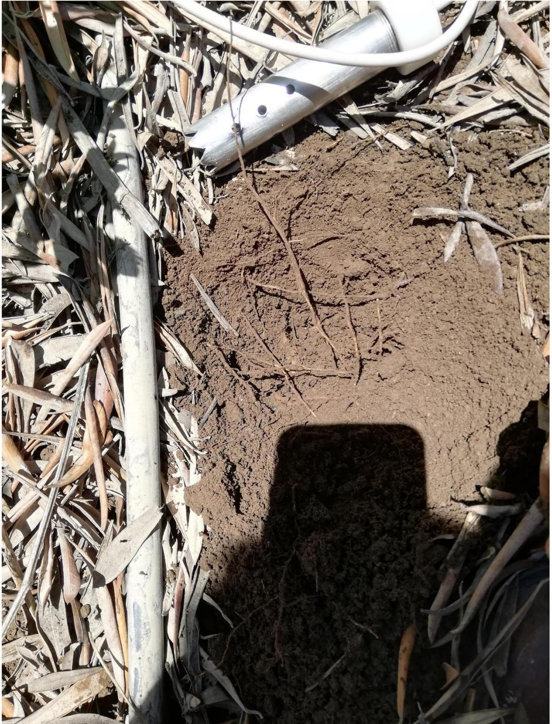
*Figura 44. Excavación para sensor de humedad de suelo*
