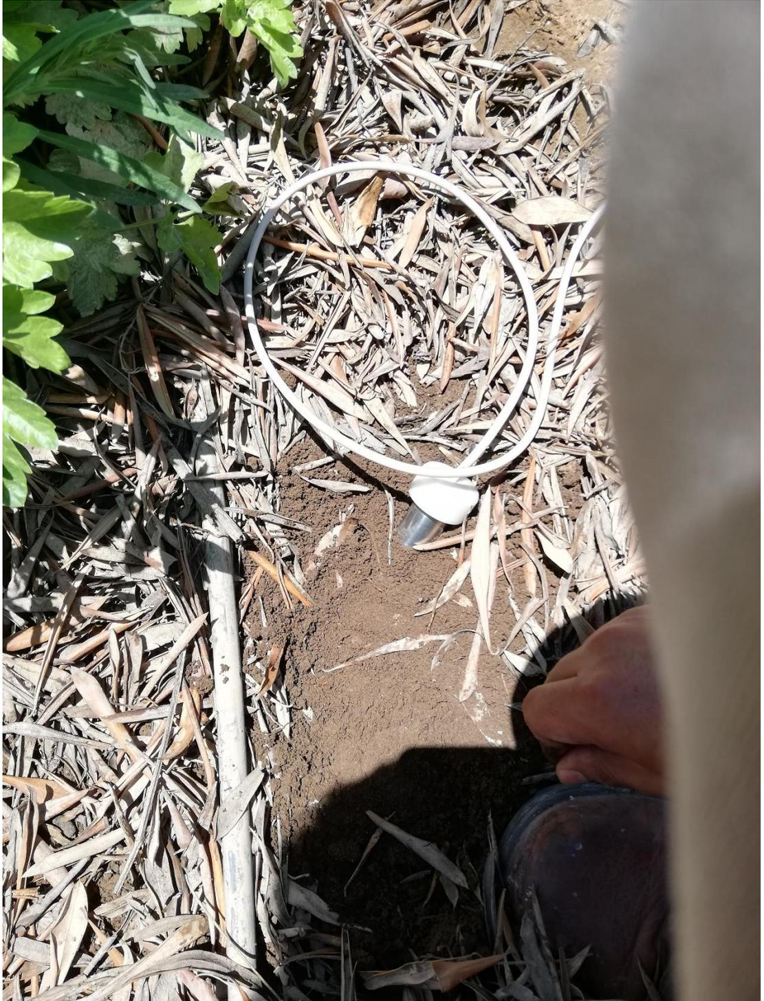
*Figura 45: Instalación de sensor de humedad de suelo.*
