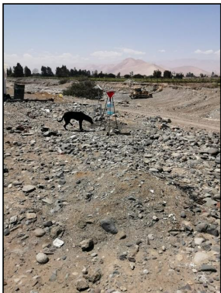
Figura 26 Instalación de Colectores de Polvo, en zona de poca accesibilidad.
