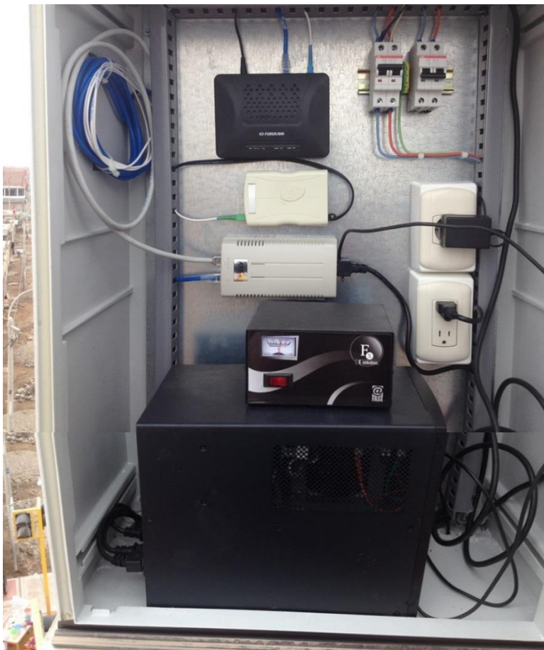
Figura 28: Dispositivos de las cajas térmicas de los postes con cámaras de la red de datos de fibra óptica del distrito CGAL Fuente: Informe de Mantenimiento de Cámaras de Videovigilancia del distrito
