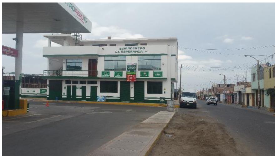
Figura 61: Frontis del Servicentro la Esperanza Fuente: Elaboración Propia
